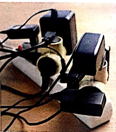
Un enchufe eléctrico sobrecargado puede causar un incendio.
